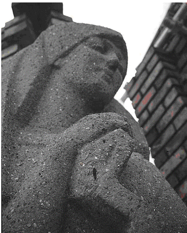
1. Église du Saint-Esprit à Paris (75). Érosion de la peau du béton et corrosion d'une armature ayant généré une épaufrure.
