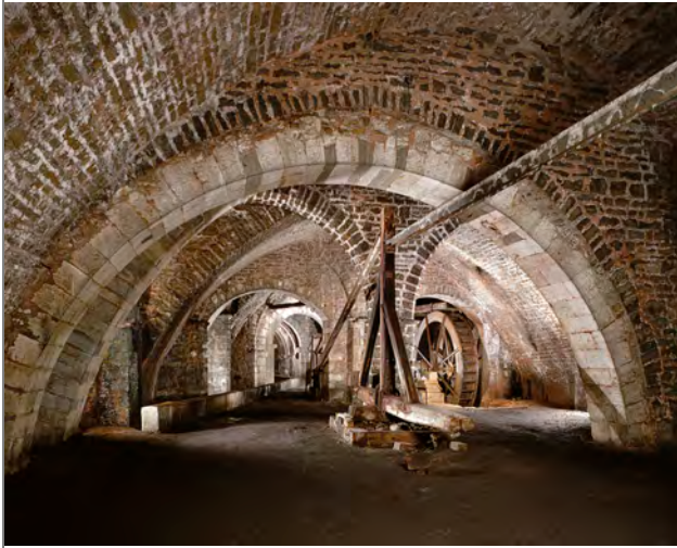
La Grande saline de Salins-les-Bains. Roue hydraulique destinée à l'échouage de la saumure dans le Grand puits. Ce système de pompage fut mécanisé en 1750 pour remplacer les traditionnels manéges à chevaux. Yves Sancy © Région Franche-Comté, Inventaire du patrimoine. ADAPF, 1985.
