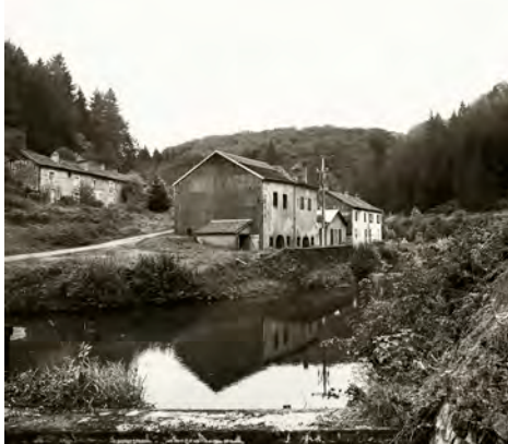
Atelier de tréfilerie de la forge de Blanc-Mesnil à Boullantierre, dans les Vosges. Édifié en 1828 et 1832, l'atelier s'éleva par paliers, par l'utilisation de matériaux locaux, dans l'architecture vernaculaire. Aiguëte est perceptible une rangée de logements ouvriers bâtis au début du 19 e siècle. A. Dagon © Région Lorraine – Inventaire général, 1988.
