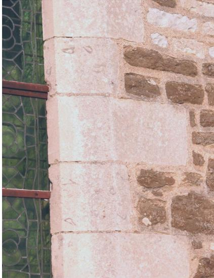
Pontigny, abbatale, fenêtre, côté sud, entourage de la baie en calcaire blanc des environs de Tonnerre et mur en moellons extraits des terrains proches de l'abbaye.
