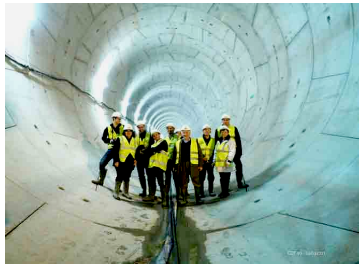
RATP – Prolongement de la ligne 12 du Métro. Intérieur du tunnel, 14 mars 2011. © CDT 93.
