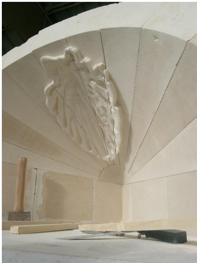
Construction d'une trompe rampante par des compagnons © Luc Tamborero
