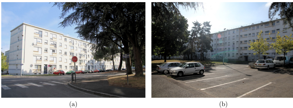
FIGURE 6.6 – Bâtiment Dunant : (a) façade sud – (b) façade nord
